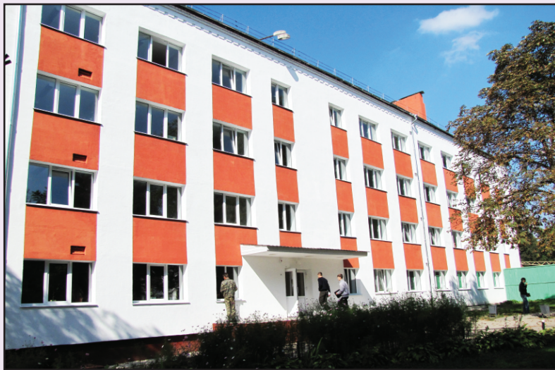
Так выглядит фасад общежития №3 после капитального ремонта
